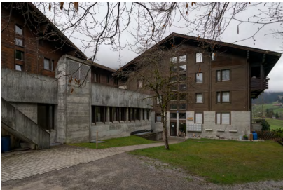
Restaurantküche mit Flachdach
