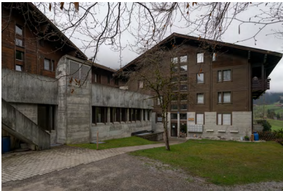
Restaurantküche mit Flachdach
